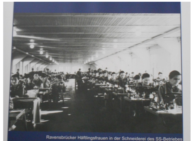
L'usine (vue de l'intérieur)
